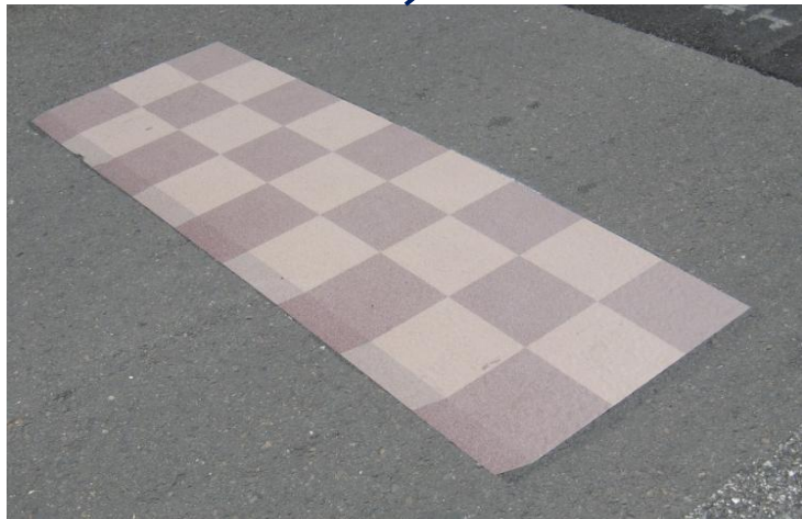
車道部の舗装
