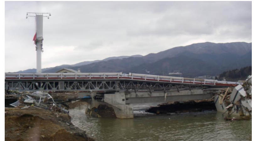
②国道45号:川原川橋復旧状況(3月25日)
