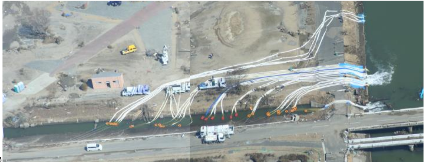
▲仙台空港周辺における排水作業
