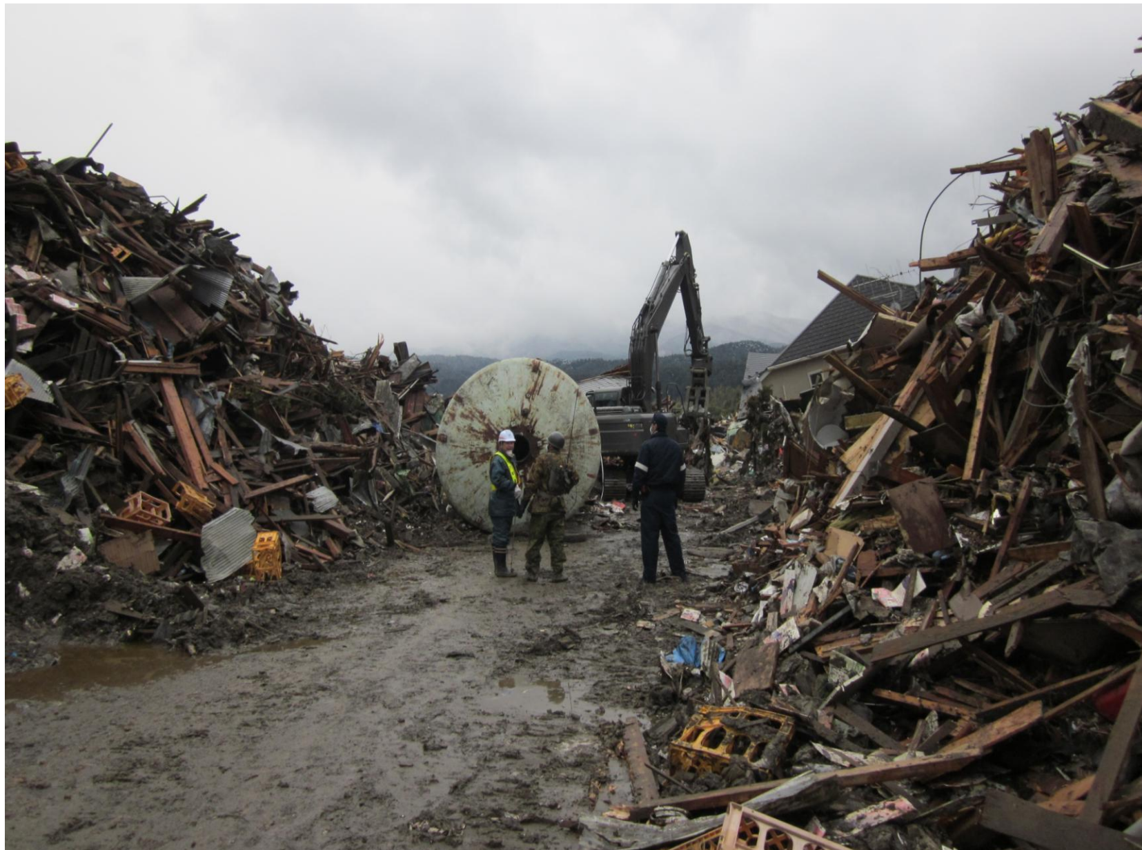
りくげんたかた ・津波により災害を受けた岩手県陸前高田市内の道路啓開状況
