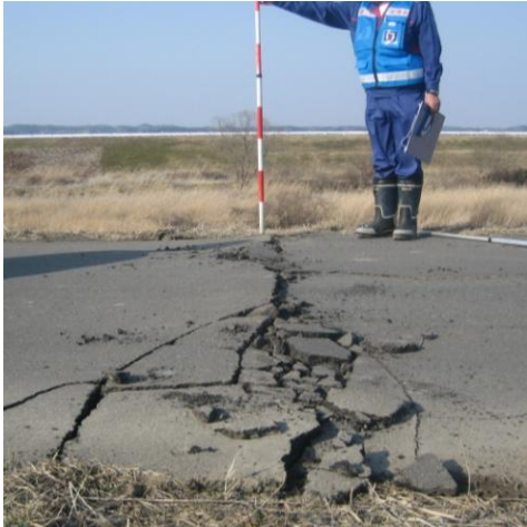
▲堤防の被災状況調査(吉田川右岸)
