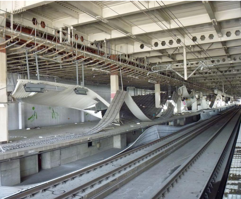
東北新幹線仙台駅及び高架橋電柱破損
