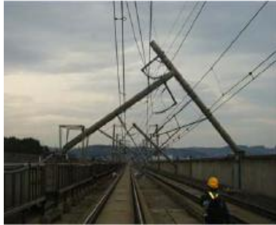
東北新幹線仙台駅及び高架橋電柱破損
