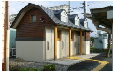
トイレ整備 (5箇所)
